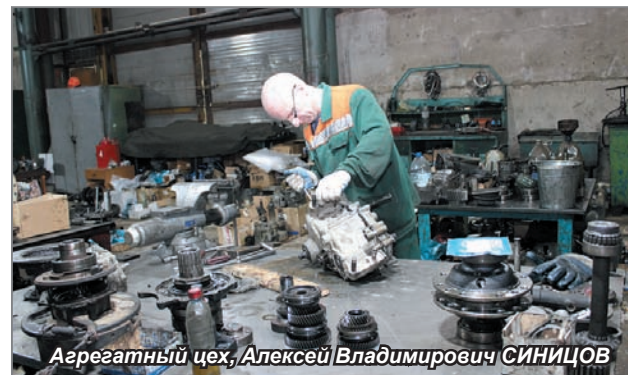
Цех по ремонту технологических установок
